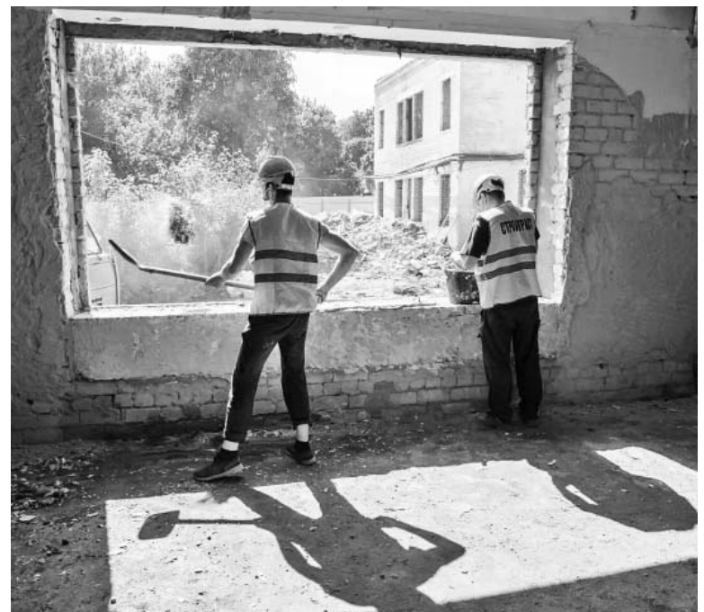
На стройплощадке подстанции №2 больницы скорой медицинской помощи (БСМП).
